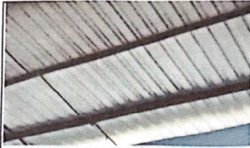
FOTO 4: Sustrucción de lámina, por lámina troquelada aluzinc calibre 25 en módulo de aulas
